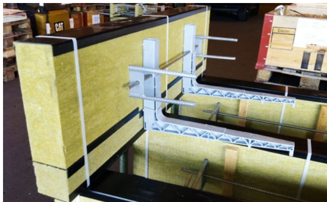
Éléments avec angles de butée de dalles et isolation supplémentaire amovible.
