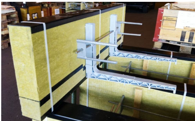
Éléments avec angles de butée de dalles et isolation supplémentaire amovible.
