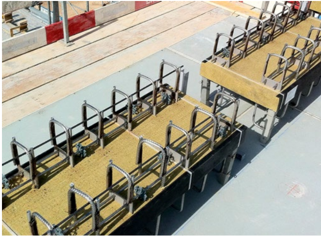
Consoles verticales pour porche en rive de toit
