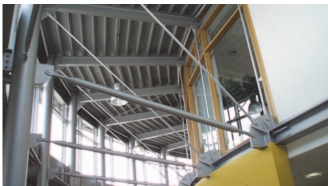
Contreventement entre un poteau extérieur en acier et une poutre intérieure en acier
