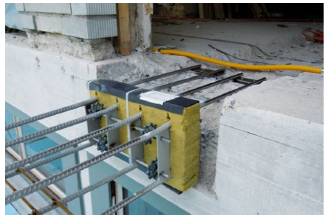
Anschluss an bestehendes Gebäude (mit Niveau-Versatz)
