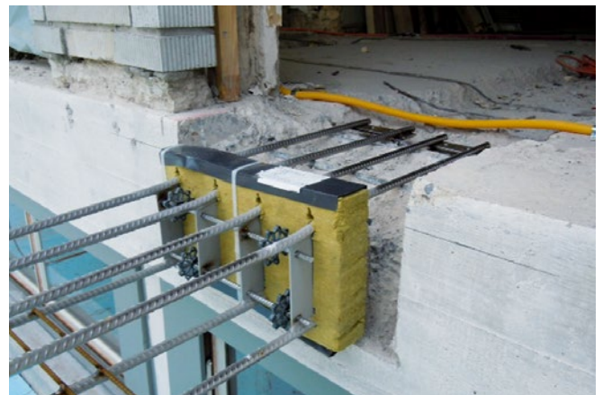
Anschluss an bestehendes Gebäude (mit Niveau-Versatz)
